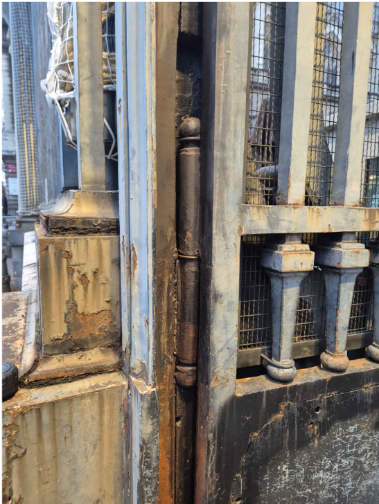
Détail système de rotation - gond
